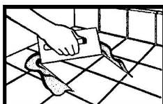
Odstraňte přebytečnou maltu hranou stěrky. Počkejte 10 – 20 minut.
